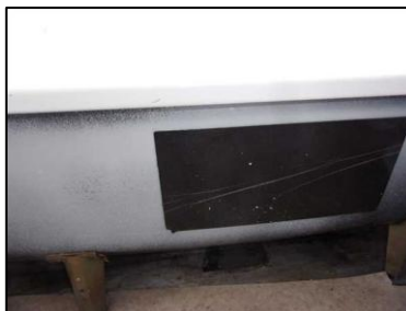
Photo N° 7 ECH-N°005 -1ER Droite-Salle de Bains Baignoire Plaque bitumineuse anti-bruit
